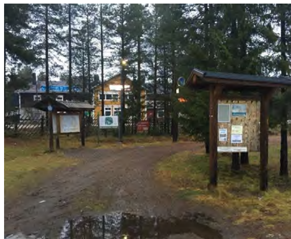
Kuva 54. Pyöräilyreiteillä varmistettava, että reitin kulutus- pinta pysyy kunnossa ja reitin kuivatus toimii kunnolla.
