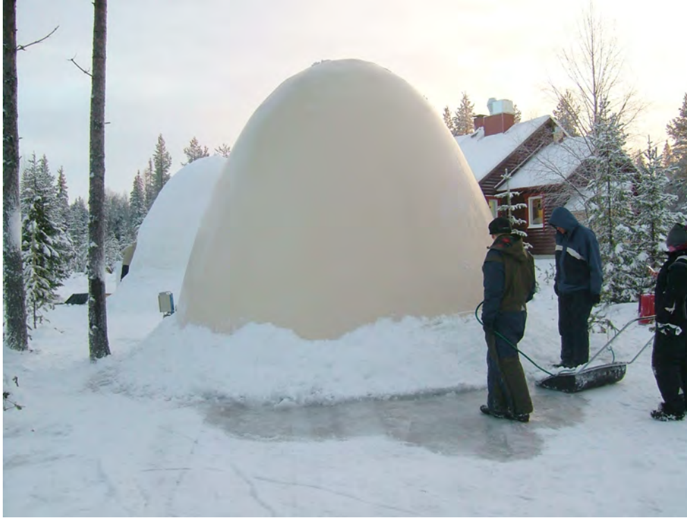
Kuva 8. Ketjukäyrän muotoinen ilmanpainemuotti 42
