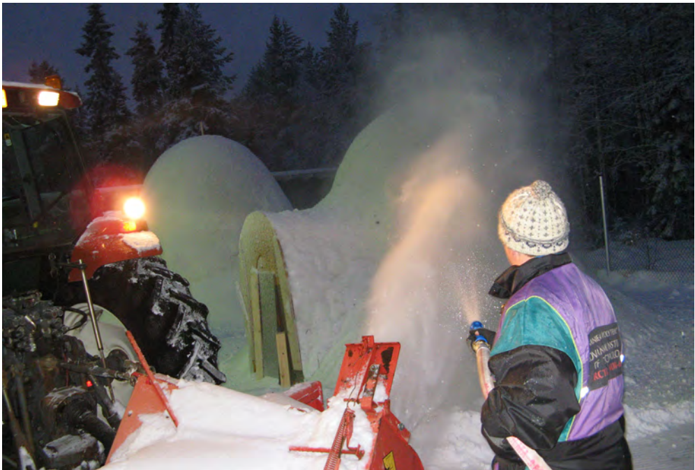
Kuva 21. Veden sumutus lumetusvaiheessa 73
