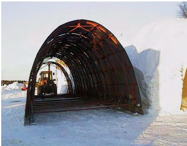
Kuva 7. Ketjukäyrän muotoinen teräksinen holvikaarimuotti 41
