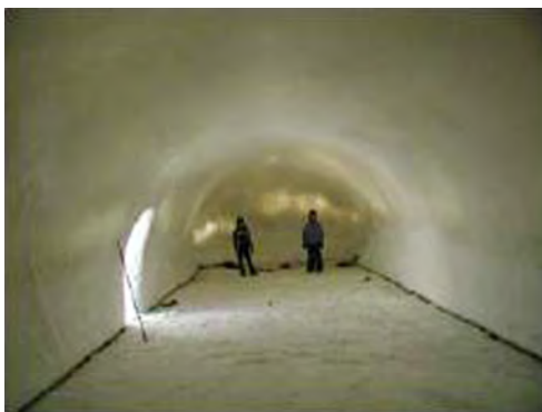
Kuva 26. Muovimuotilla tehty lumigalleria 83
