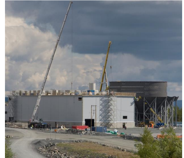
Kuva: Yaran rikastushiekan käsittelylaitos rakenteilla toukokuussa 2016.
